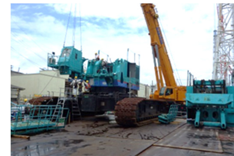
写真④ クレーン組立 (4号機原子炉建屋西側)
