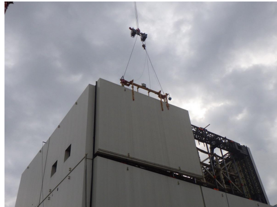
壁パネル取り外し状況（西面）
