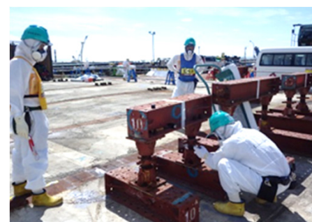
写真③ 地組ヤード整備 (2号機タービン建屋東側)
