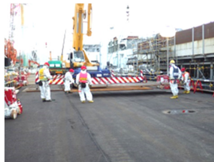
写真② 40mm鉄板敷設
