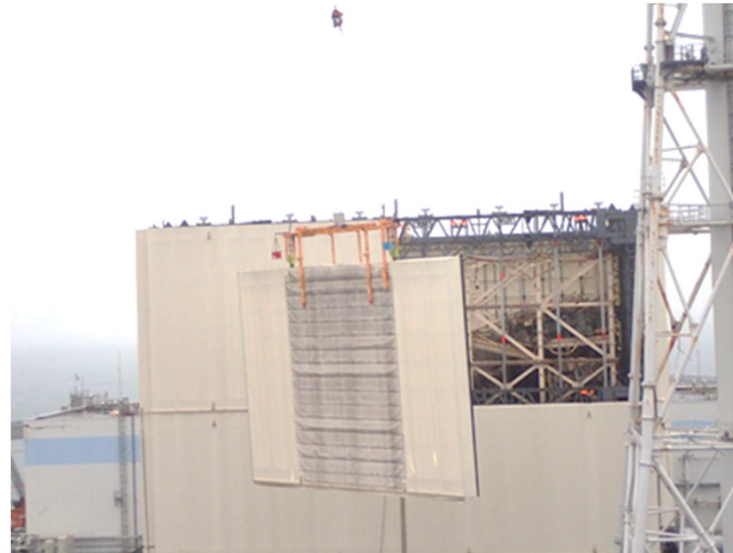
壁パネル吊り下し状況
