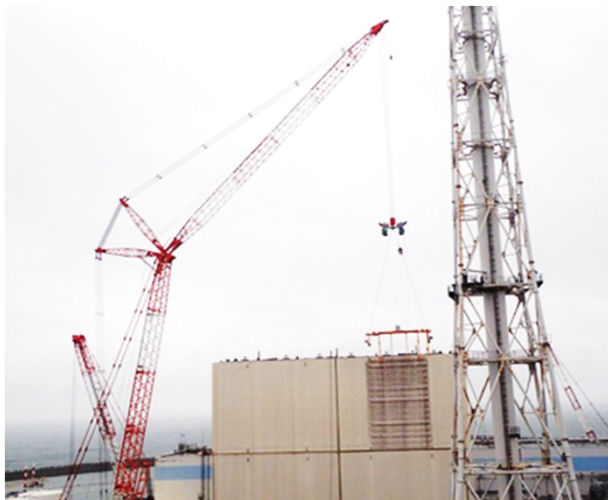
壁パネル吊り上げ前状況
