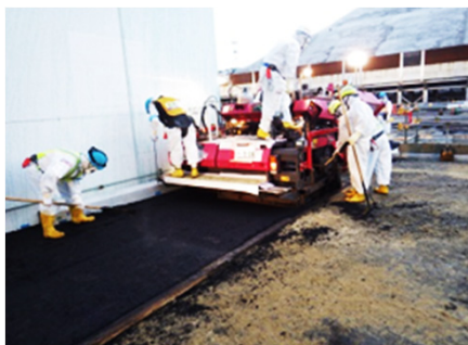
写真① アスファルト舗装
