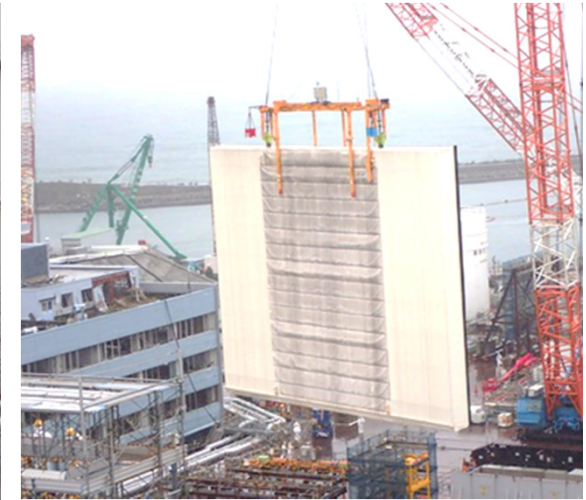
壁パネル吊り下し状況（拡大）
