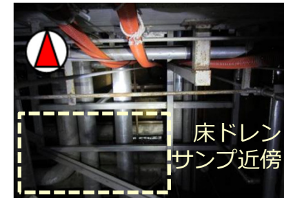
1階開口部から床ドレンサンプ近傍を見下ろした状況
