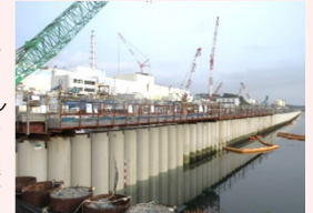
海側遮水壁 鋼管矢板打設完了状況
