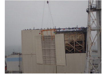
(1号機建屋カバー壁パネル取外状況)
