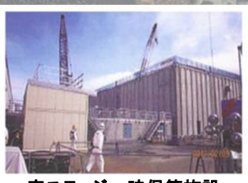
廃スラッジ一時保管施設
