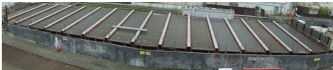
【逆洗弁ピット上部の屋根設置状況】
