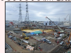
H1東エリア解体後の様子
