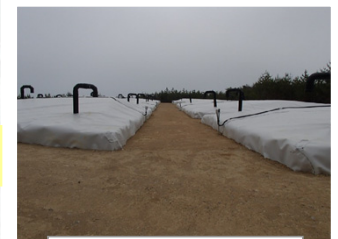
伐採木一時保管槽
