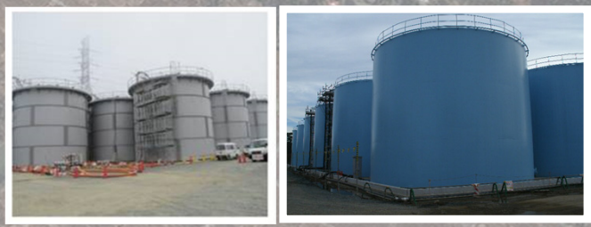
タンクの設置状況
