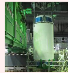
燃料取り出し状況
