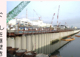
海側遮水壁 鋼管矢板打設完了状況
