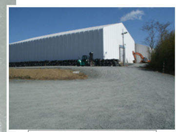
瓦礫保管テント
