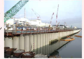
海側遮水壁 鋼管矢板打設完了状況
