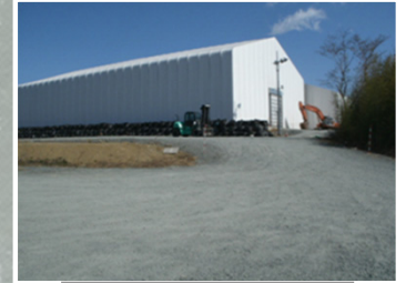
瓦礫保管テント
