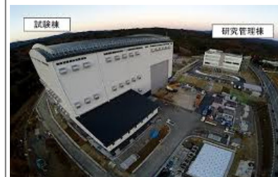
楢葉遠隔技術開発センター
