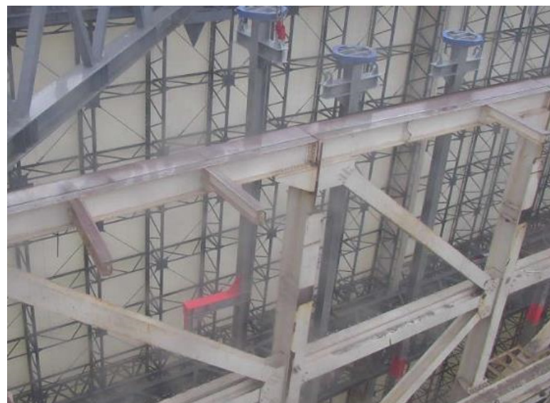
設置状況（東面）
