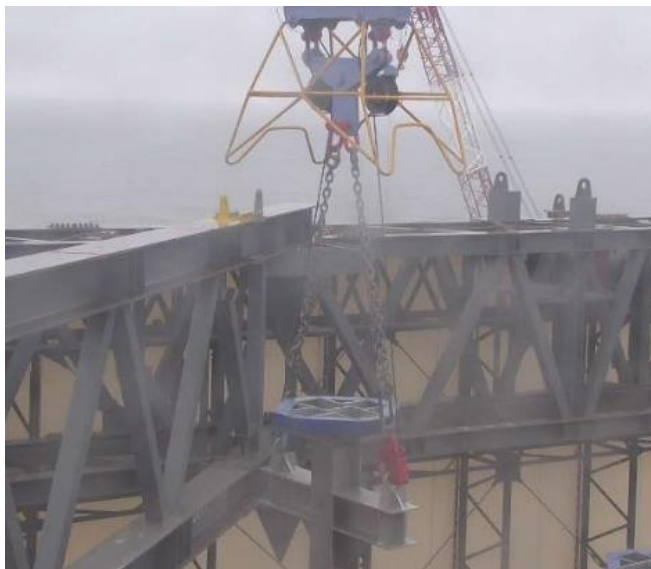
吊り上げ状況（東面）
