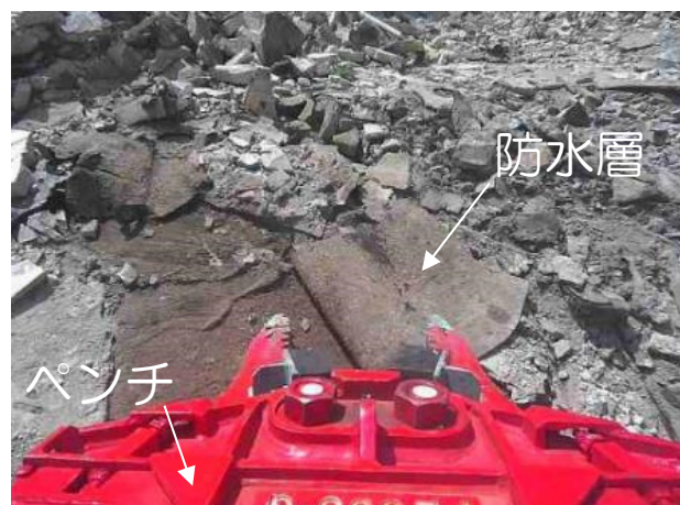
②防水層剥がし
