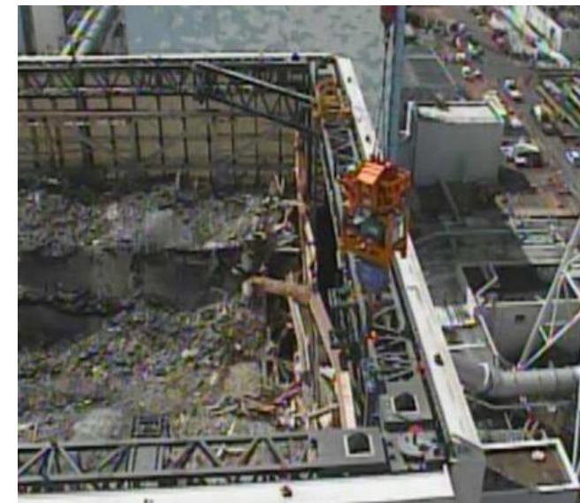
吊り上げ状況（西面）
