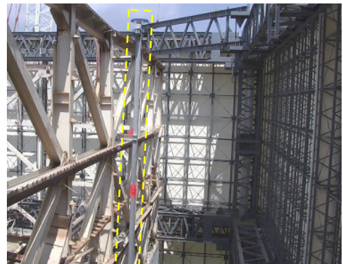
撮影：H28.4.6 ノズルユニット設置状況（東面）
