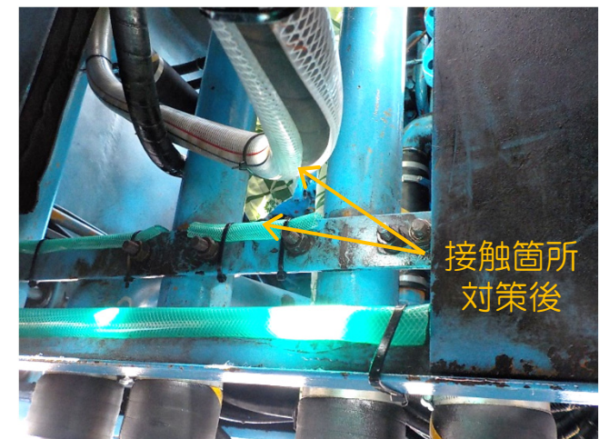
接触箇所補修状況
