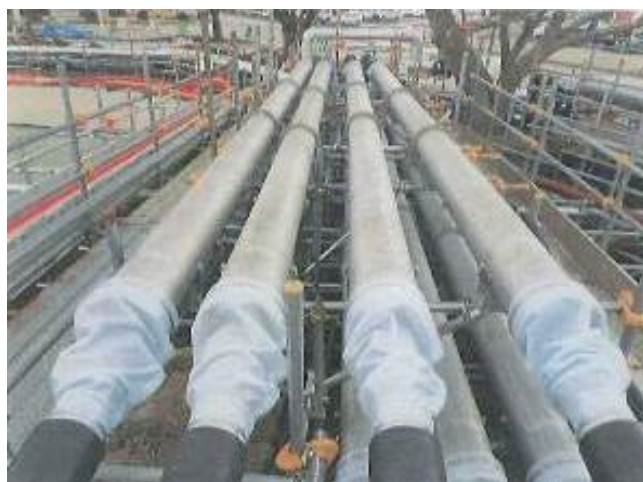
【構内排水路横断部の二重管化】
