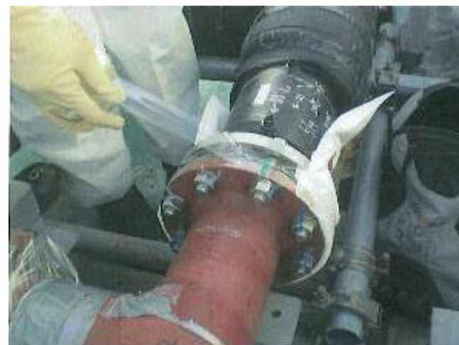
【移送配管フランジ部の吸水材取付】
