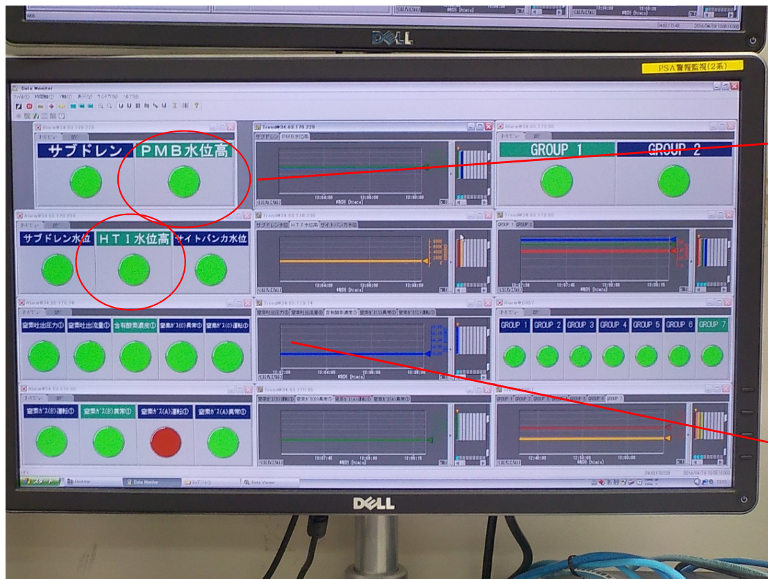
監視画面全景
