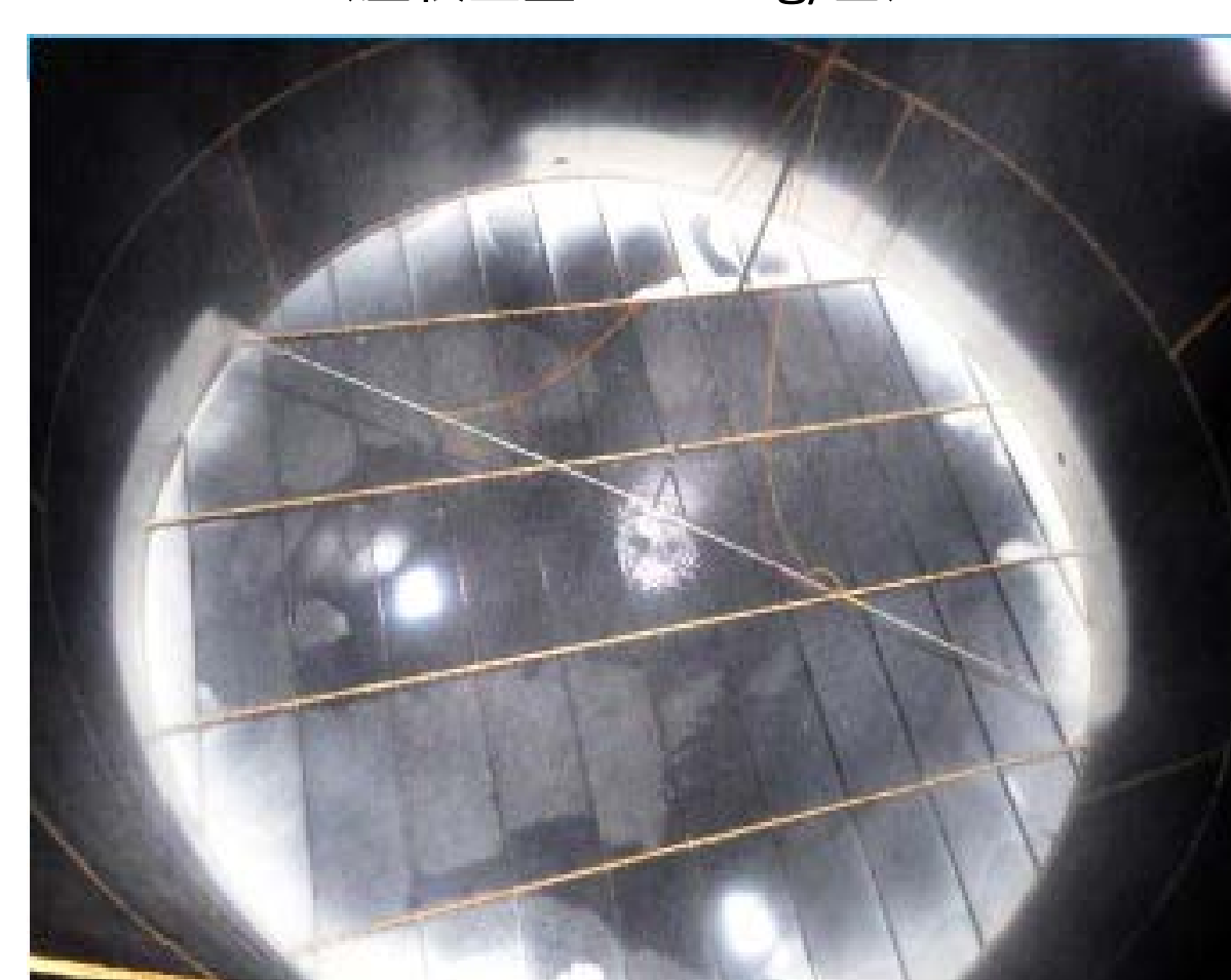
飛散抑制材のタンク内面無人化塗装
