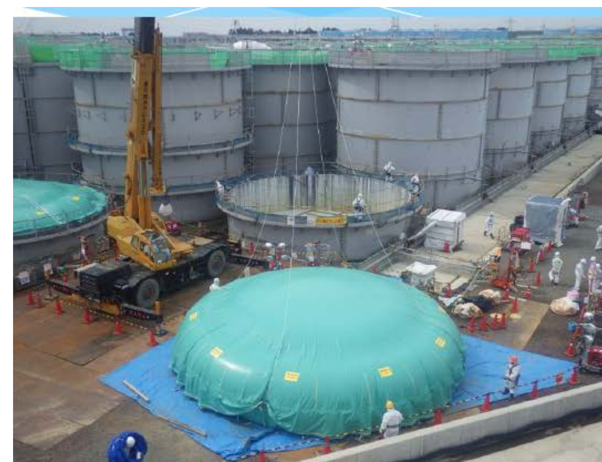
飛散抑制のための屋根を設置 （屋根重量＝300kg/基）
