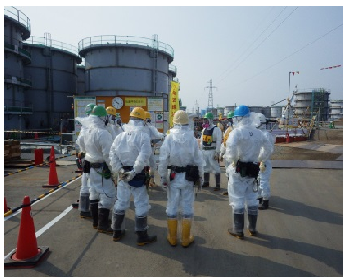
現場での徹底した危険予知活動(TBM)-KY
