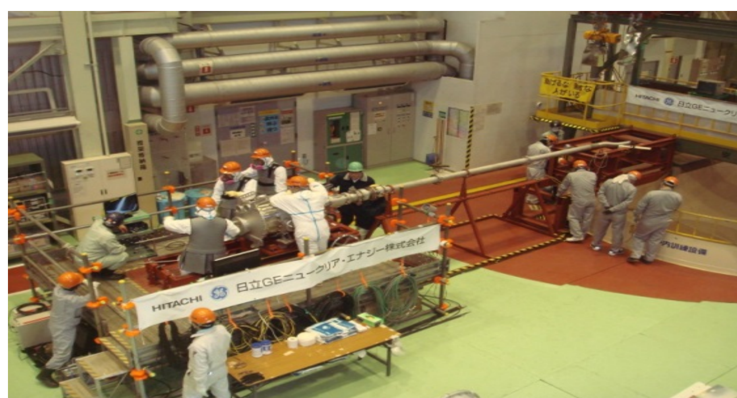
工場でのロボット投入トレーニング設備と作業状況
