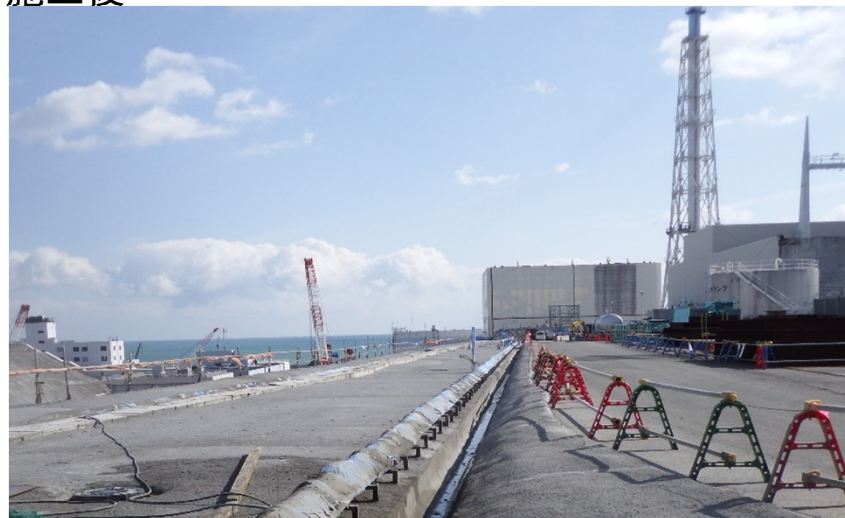
【写真④(35m盤)】山側法面エリア:大熊通り法肩部モルタル施工後
