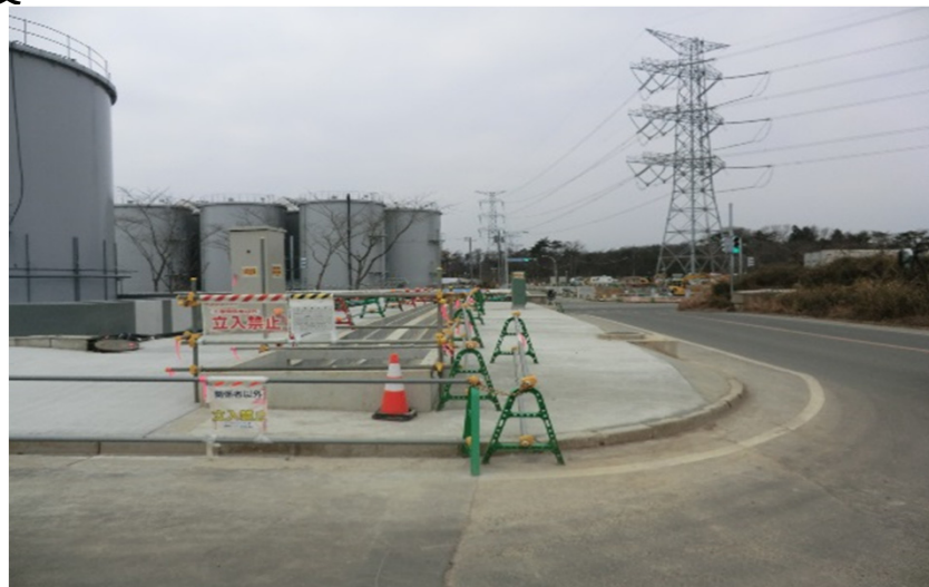
【写真⑤(35m盤)】西側エリア:中央通りモルタル舗装施工後
