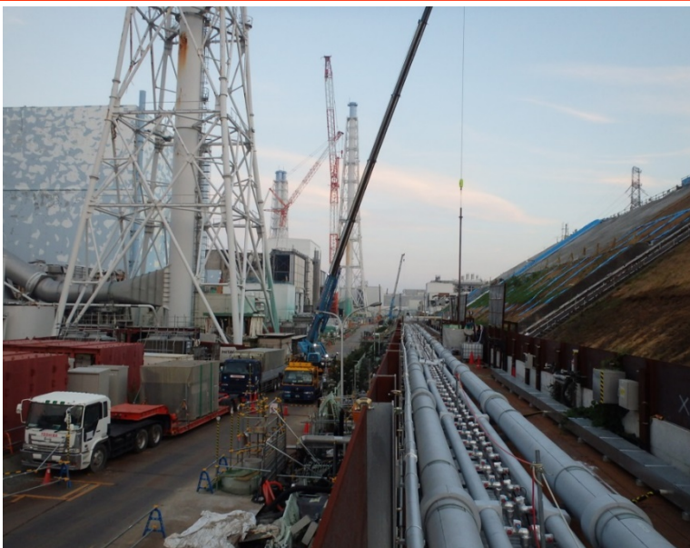
2～4号建屋西側 施工完了状況
