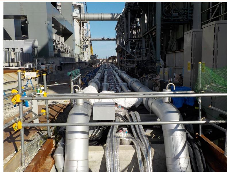
4号機建屋南側 施工完了状況
