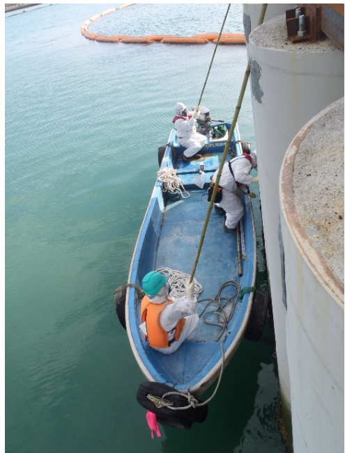
海側遮水壁の外観目視点検状況
