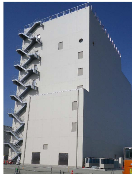
大型休憩所（外観）
