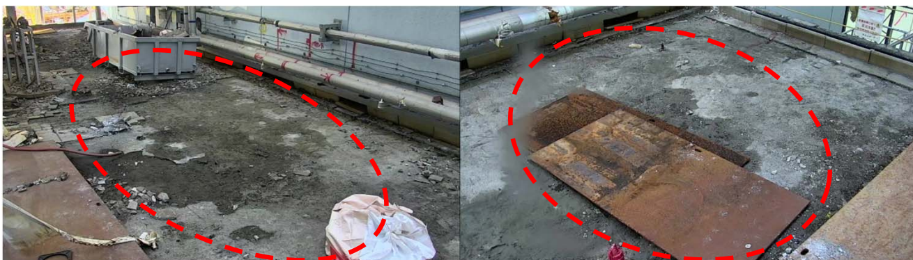
原子炉建屋下屋（東側）でのガレキ吸引作業後 散水ノズルまでの配管設置等の作業状況写真
