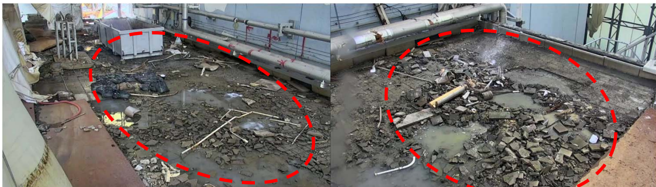
原子炉建屋下屋（東側）でのガレキ吸引作業前
