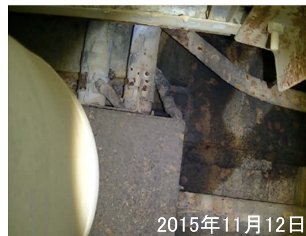
1号機コントロールケーブルダクトからの流入状況
