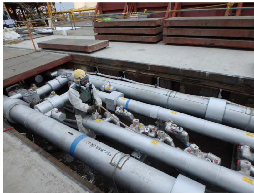
【ブライン充填後のエア抜き作業】
