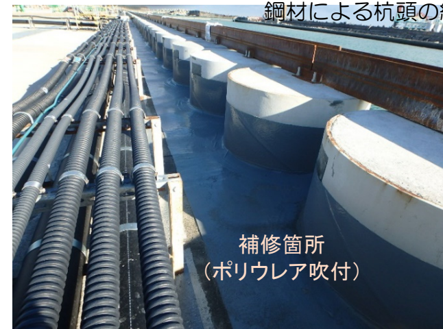
鋼管矢板際の状況（補修実施後） （ポリウレタ吹付箇所の一例）
