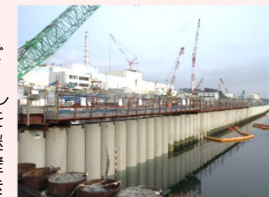
海側遮水壁 鋼管矢板打設完了状況
