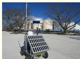
<線量率モニタ設置状況>
