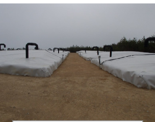
伐採木一時保管槽
