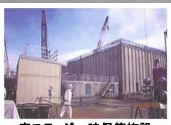
廃スラッジ一時保管施設
