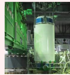
燃料取り出し状況
