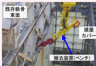
支障鉄骨の撤去作業の状況
