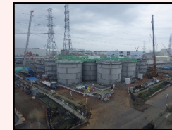
解体開始時の様子
