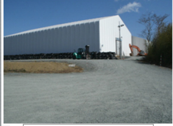
瓦礫保管テント
