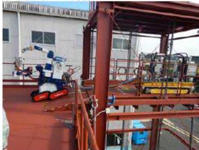
■ 作業台車 上部階進入
