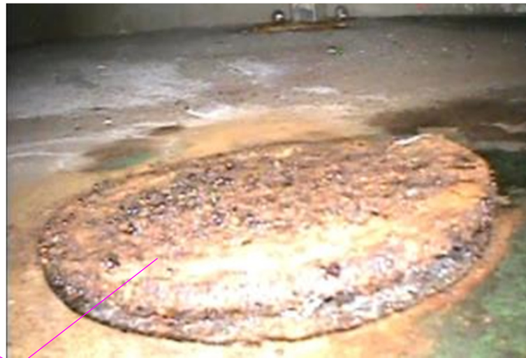
写真⑤：床ドレンファンネルの状況
