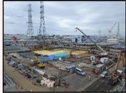
解体後の様子
