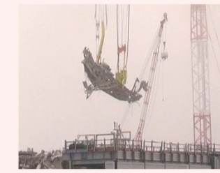
8/2 燃料交換機撤去作業の様子
