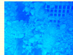
<使用済燃料プール内の状況（ラック上部より撮影）>
