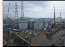
解体開始時の様子
