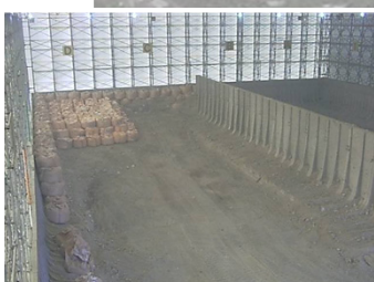
瓦礫保管テント内
