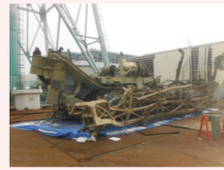
撤去した燃料交換機
