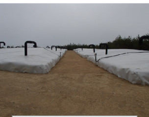
伐採木一時保管槽
