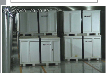
固体廃棄物貯蔵庫
