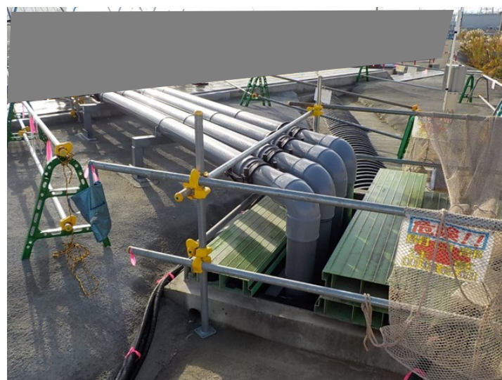
写真② 地下水BP→B排水路への 移送配管設置状況
