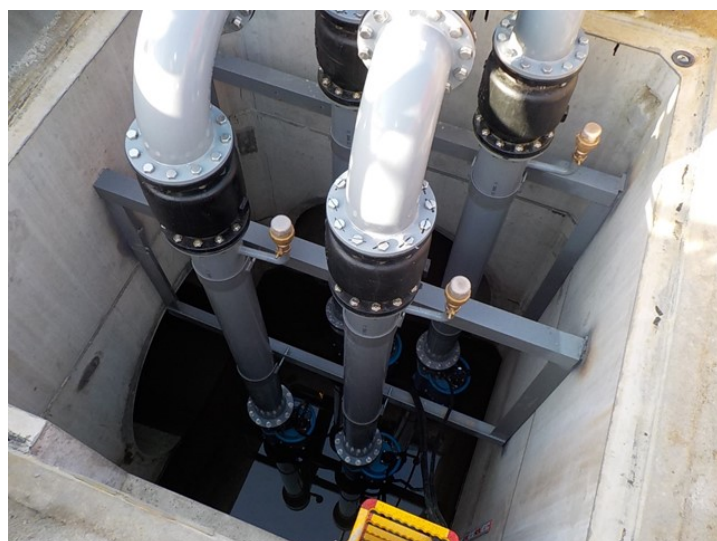
写真① 地下水BPエリア枝排水路 ポンプ(4台)設置状況
