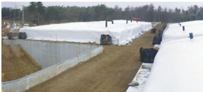
伐採木 枝葉の一時保管槽
