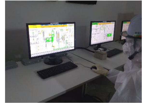
制御室 試験作業状況
