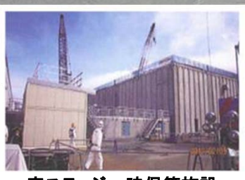
灰スラッジ一時保管施設
