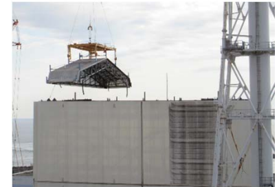
(1号機建屋カバー解体作業の状況)
