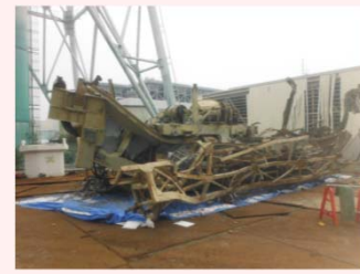
撤去した燃料交換機
