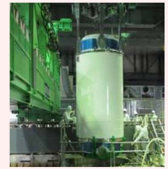
燃料取り出し状況
