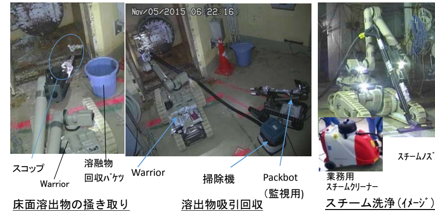
図5：2号機X-6ペネ周辺除染状況
