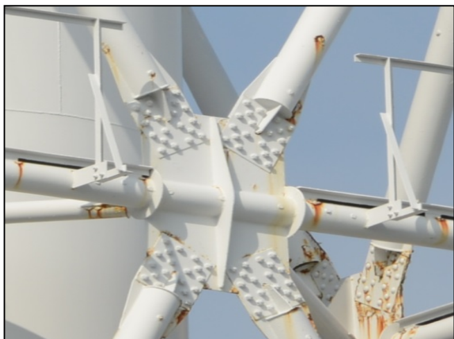
① 南側（GL100m付近） 接合部
