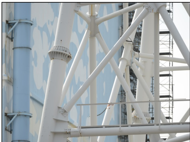
③ 北側（GL19～30m付近） 主柱・斜材
