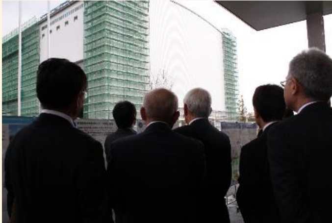
試験棟工事状況(遠景)視察
