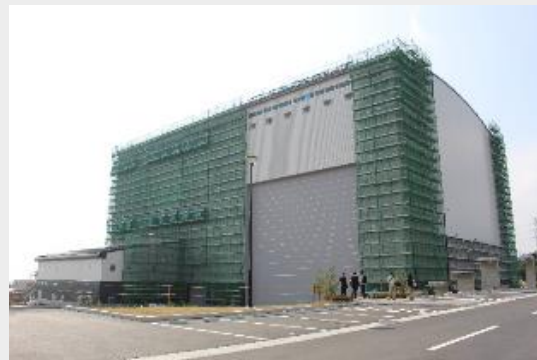
試験棟(建設中)
