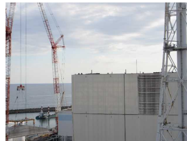
建屋付近から撮影
