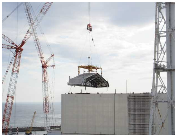
建屋付近から撮影
