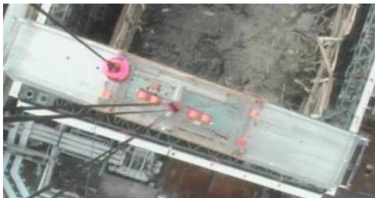
クレーンから撮影
