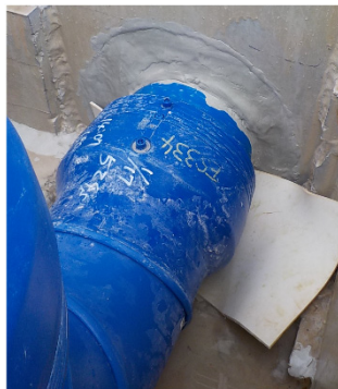
既存堰配管貫通部配管周囲を既存堰側から止水
