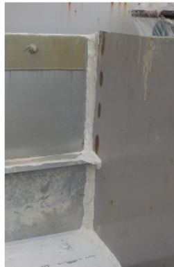
漏えい箇所外側のコーキングを実施
