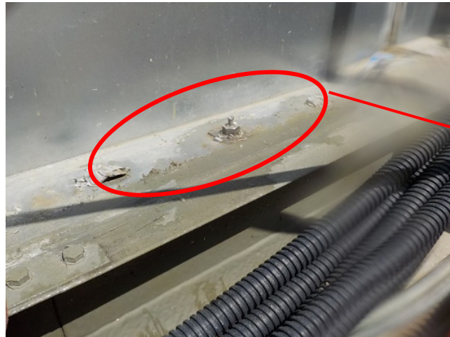
取付ボルト部
