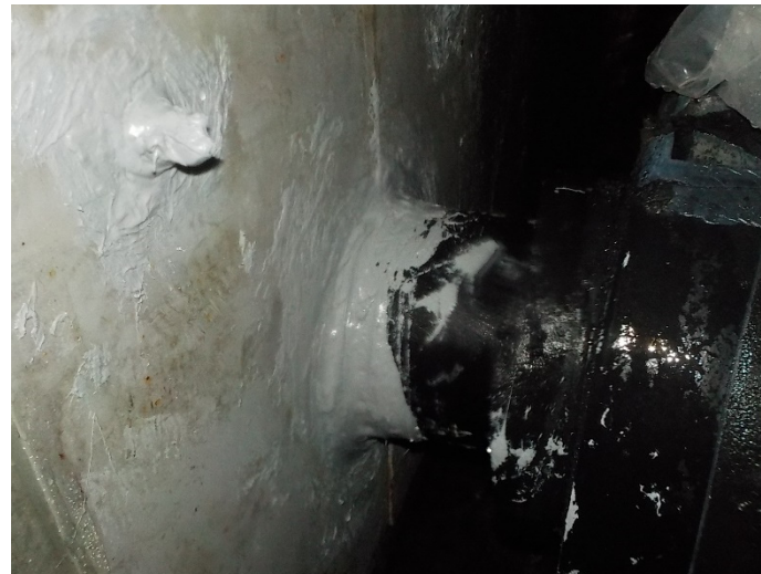
応急措置実施状況
