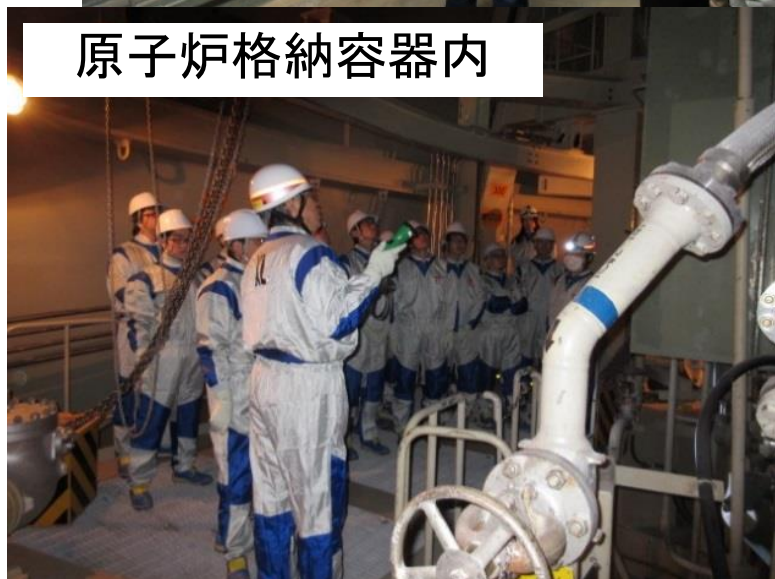
原子炉格納容器内 (制御棒駆動水圧系配管)
