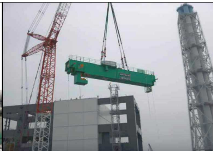
クレーン部材吊り上げ (撮影日：2013年6月7日)
