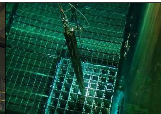
共用プールへの格納(変形燃料) (2013年11月4日撮影)
