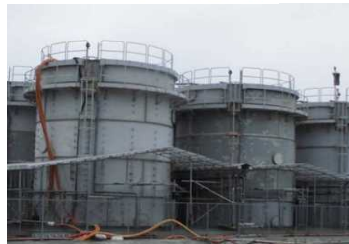
タンク堰内雨水への対応状況
