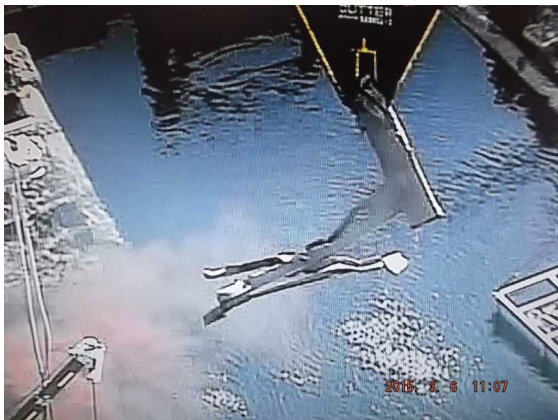
燃料交換機西側フレーム撤去作業状況 2015.3.6
