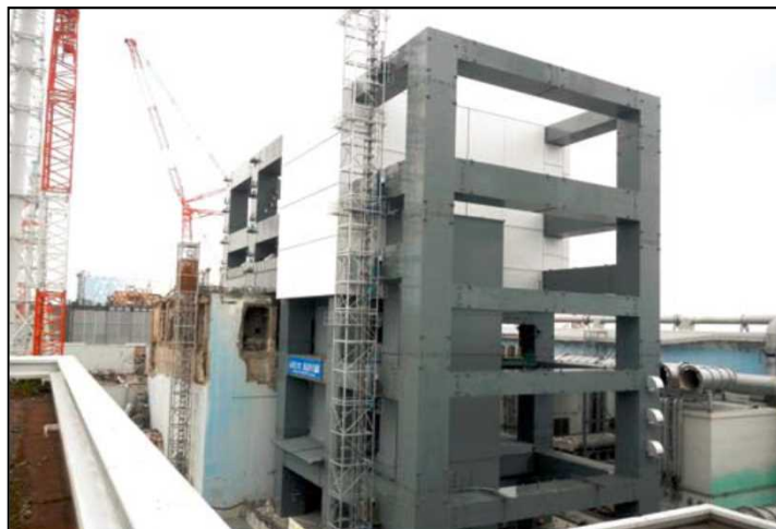
鉄骨建方完了 (撮影日：2013年5月29日)
