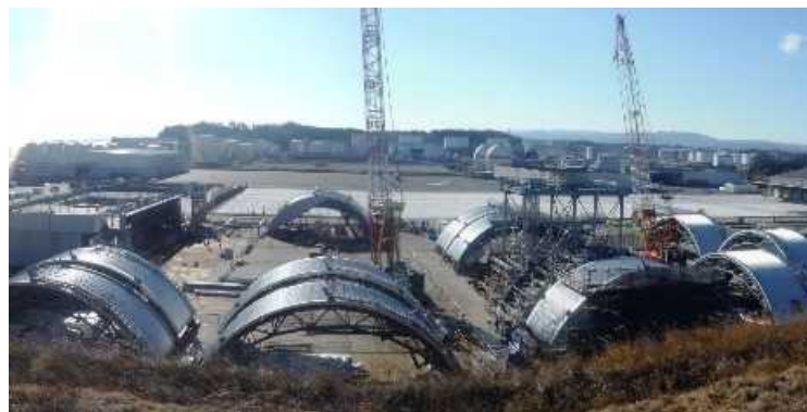
建屋カバーの製作状況（小名浜）
