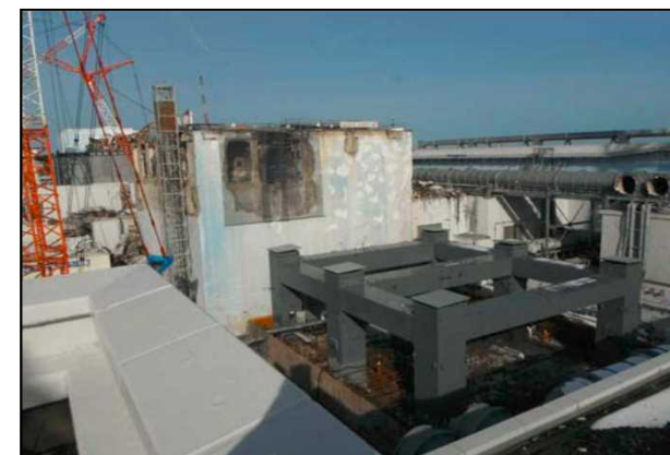
第一節 鉄骨建方完了 (撮影日：2013年1月14日)
