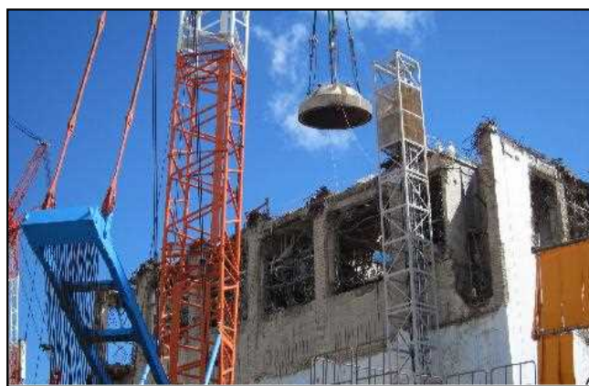
圧力容器上蓋の撤去 (撮影日：2012年9月13日)
