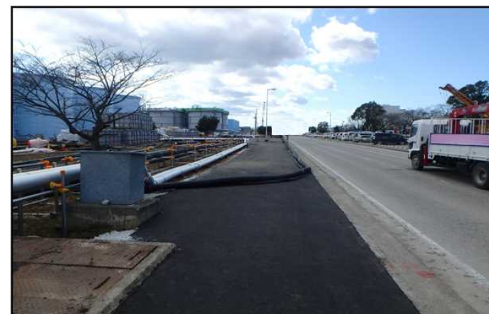
【写真】Hタンクエリア：舗装施工後
