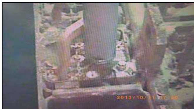
燃料ラック上部ガレキ吸引作業 (撮影日：2013年10月11日)
