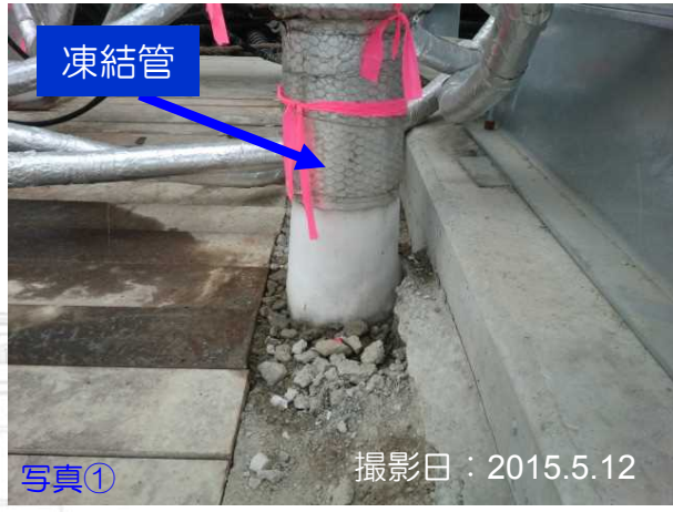
試験凍結管着氷状況
