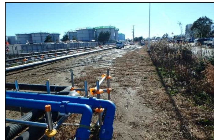
【写真】Hタンクエリア：舗装施工前
