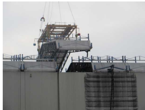
1号機建屋山側より撮影
