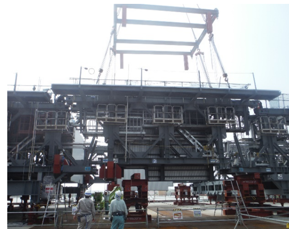
ガーダーの組立状況（2014.6.23撮影）
