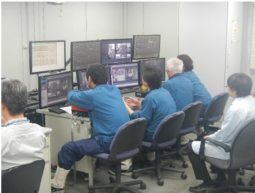
遠隔操作訓練状況写真（遠隔操作室）
