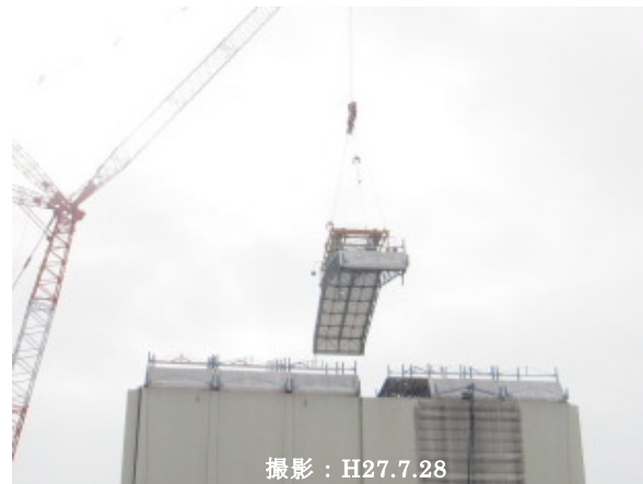
□ 作業進捗 屋根パネル取外し(北3)
