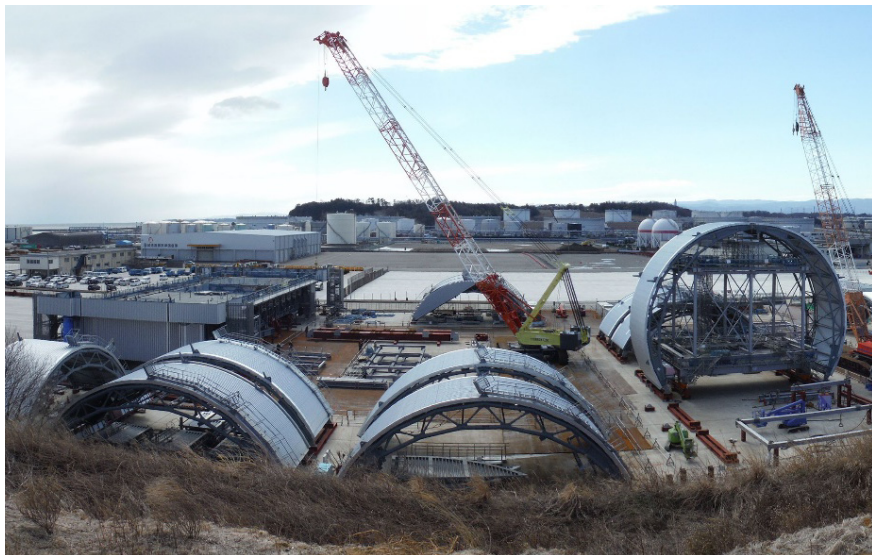
カバー架構部材の保管状況（2015.3.10撮影）
