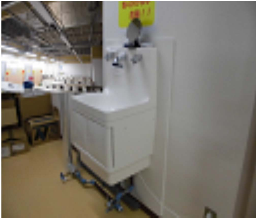
西側壁面に手洗い場新設
