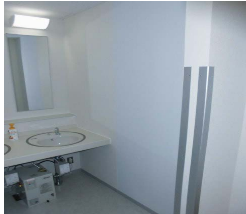
トイレ手洗い場（改修後）
