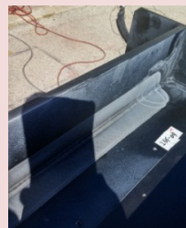
塗装剥離後の一例
