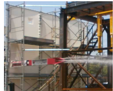
壁パネル外し前に壁パネルに孔をあけ、側面からガレキに飛散防止剤を散布
