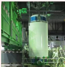
燃料取り出し状況
