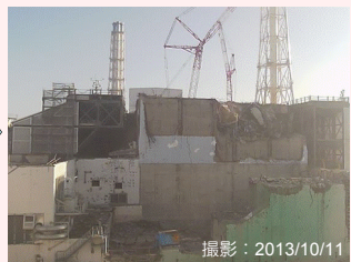
大型ガレキ撤去後
