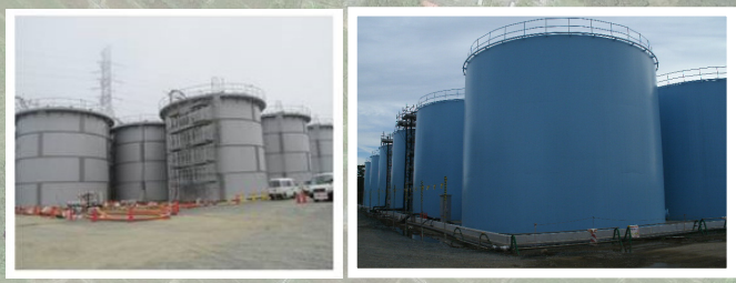
タンクの設置状況
