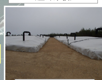
伐採木一時保管槽
