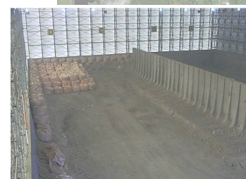
瓦礫保管 テント内
