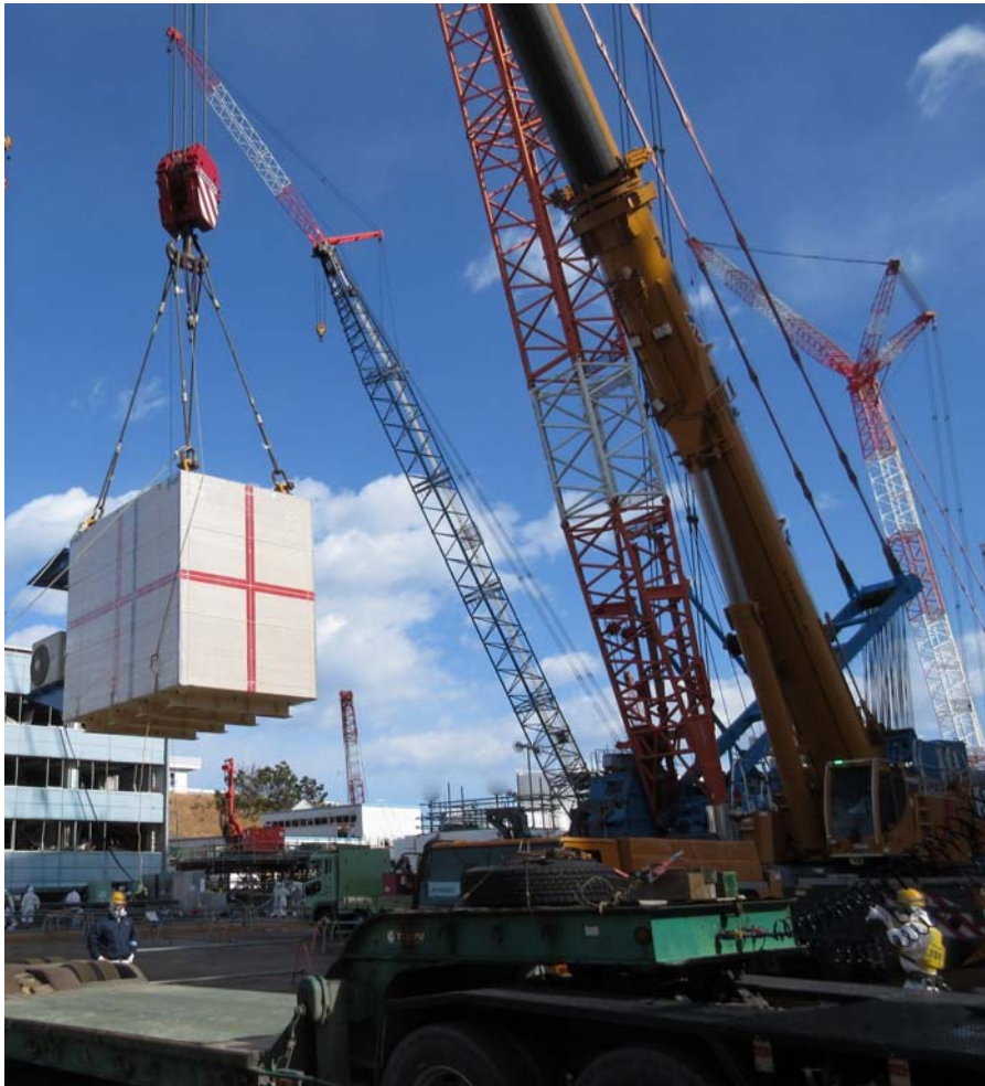
写真1 クレーンによる荷下ろし作業
