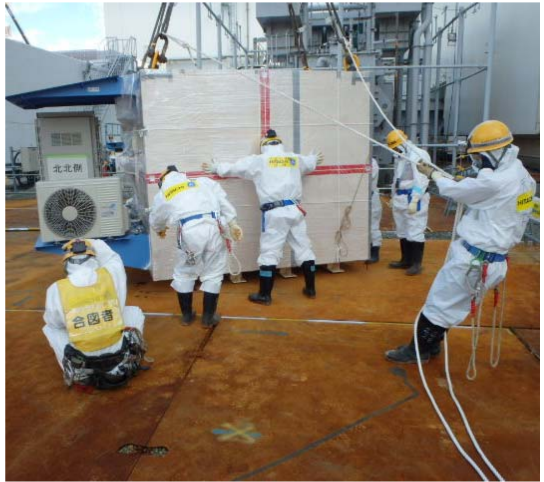
写真2 測定装置2(北側)の設置作業
