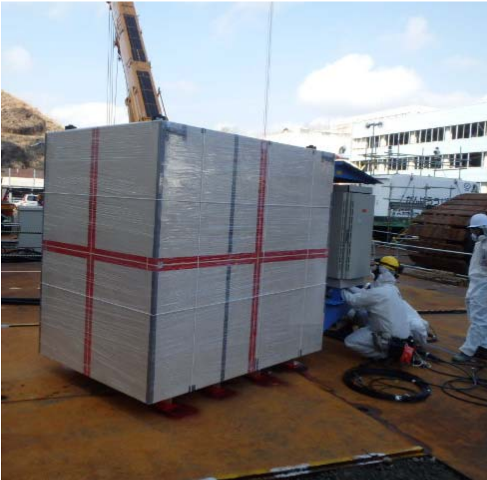
写真5 測定装置1(北西側)でのケーブル接続作業
