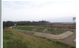
覆土式一時保管施設
