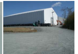
瓦礫保管テント
