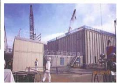
廃スラッジ一時保管施設
