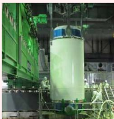
燃料取り出し状況
