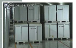
固体廃棄物貯蔵庫
