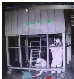
フレーム製作型遮へい体
