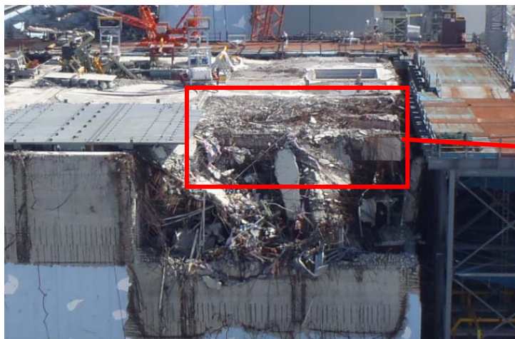
写真①R/B北側状況
