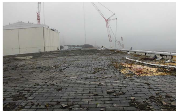
1号機タービン建屋屋上
