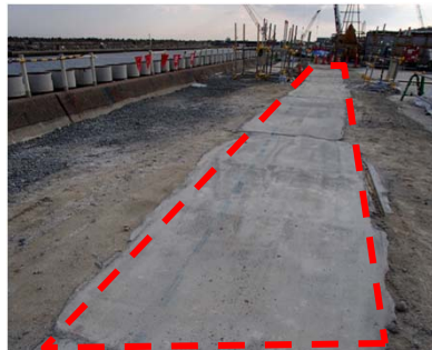
①モルタル置換完了
