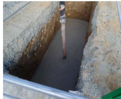
②モルタル置換施工
