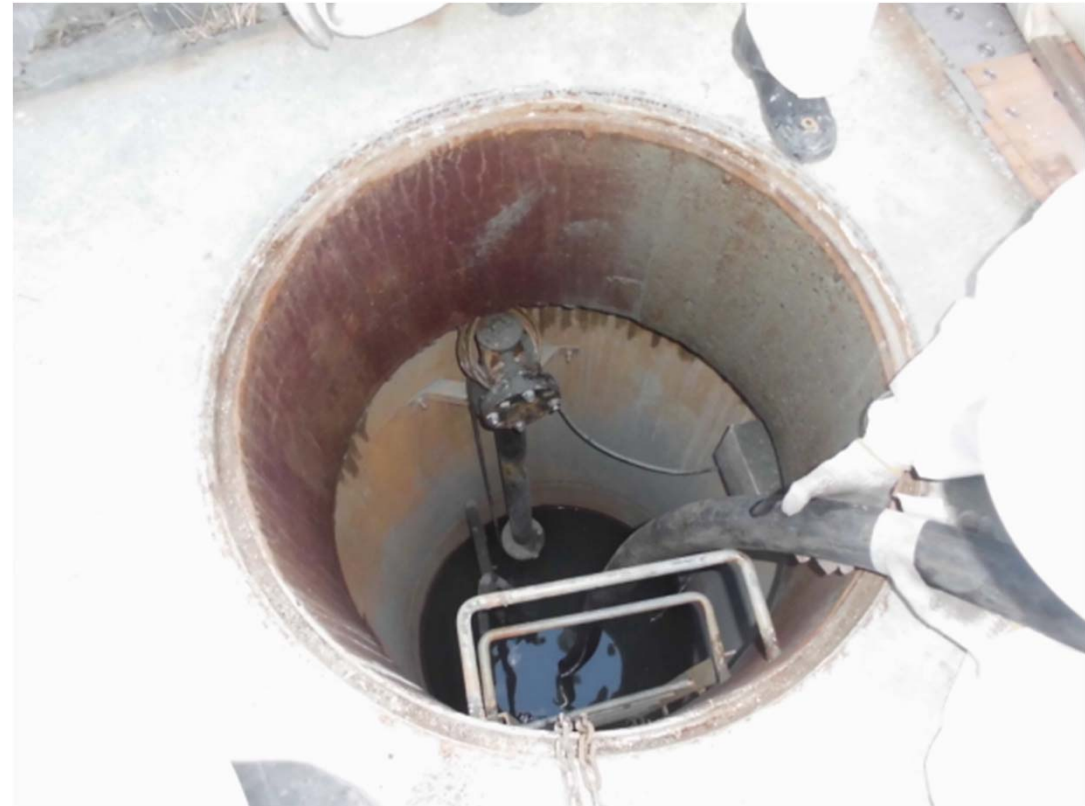
充填材打設状況
