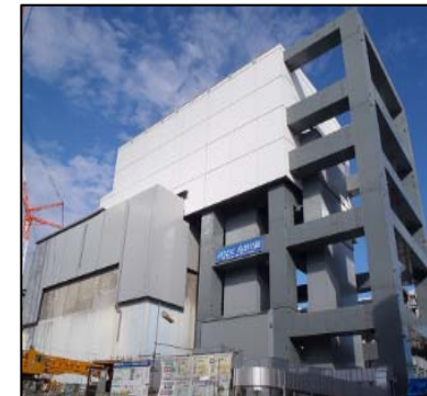
④燃料取り出し用カバー完成
