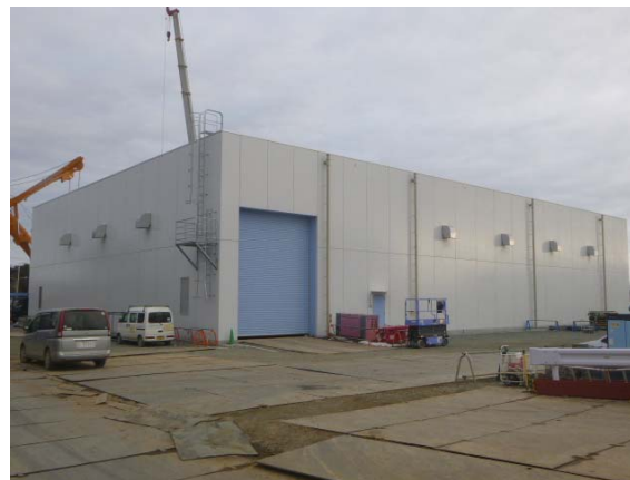
サブドレン浄化設備建屋全景
