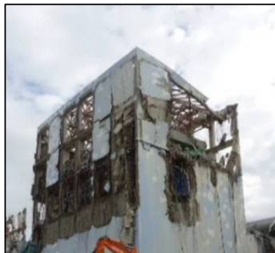
①原子炉建屋ガレキ撤去作業前
