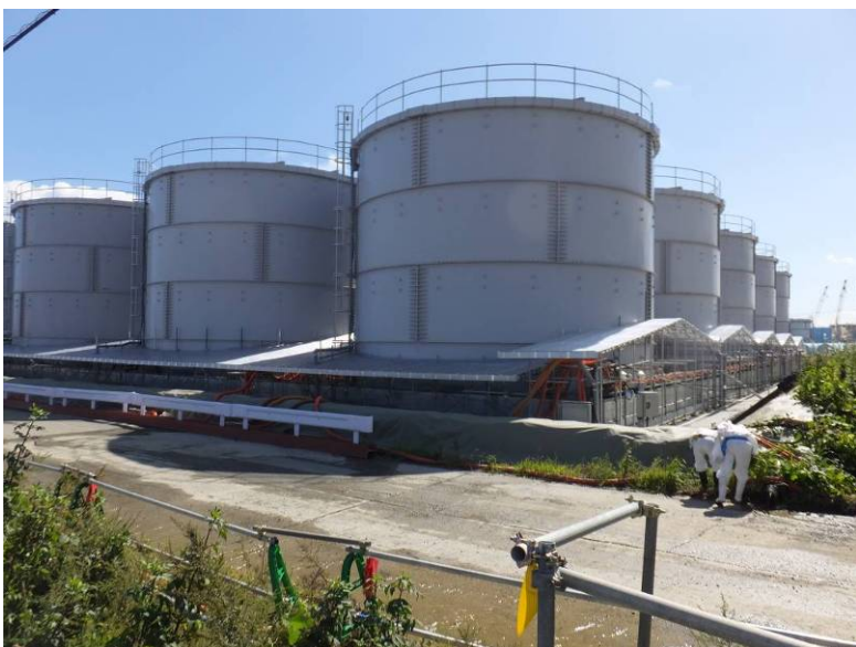
H3タンクエリア 堰カバー設置完了状況
