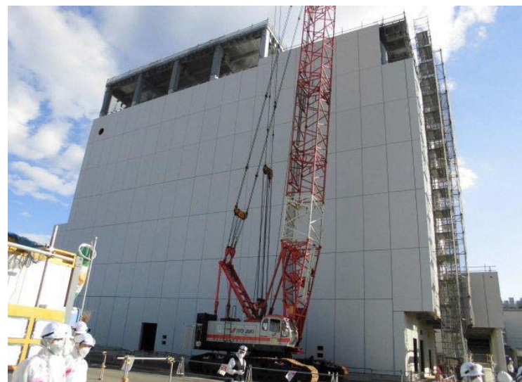
【現状】外壁工事实施中
