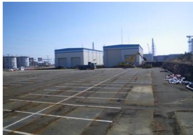
Dエリアノッチタンク撤去後
