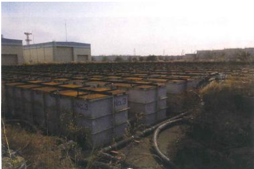
Dエリアノッチタンク撤去前
