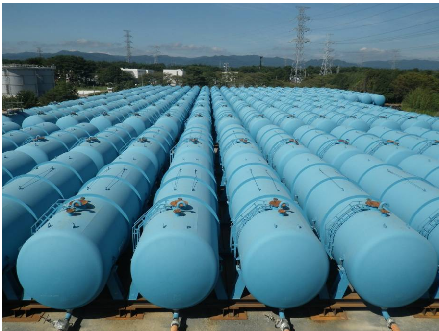
作業前 H1 エリアブルータンク状況
