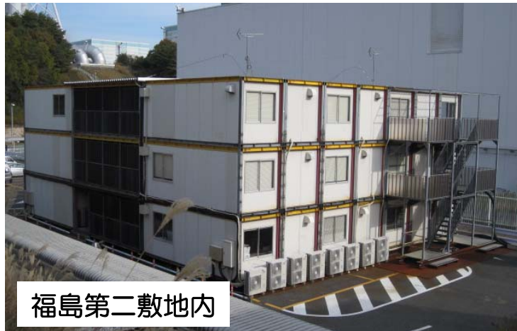
新事務棟完成前
