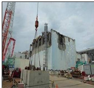
②原子炉建屋ガレキ撤去作業後
