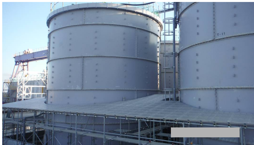
G6タンクエリア 堰カバー設置完了状況
