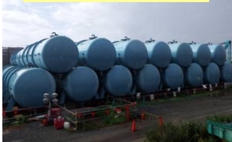
Gエリア 撤去タンク保管状況
