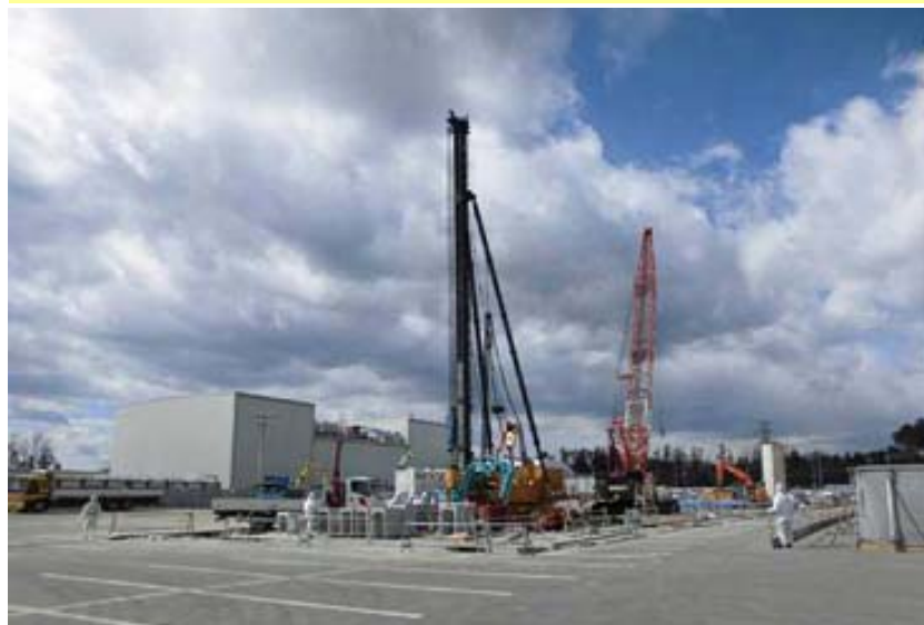
【前回公表時】基礎工事实施中
