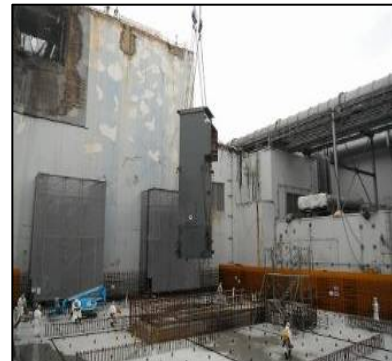
③燃料取り出し用カバー工事着手
