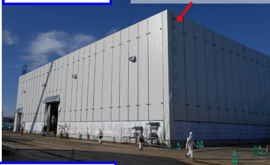
増設多核種除去設備用 サンプルタンク
