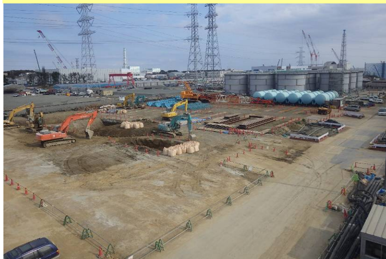
H1 エリアブルータンク作業状況
