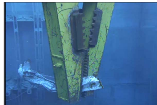
＜使用済燃料プール内瓦礫撤去作業状況＞
