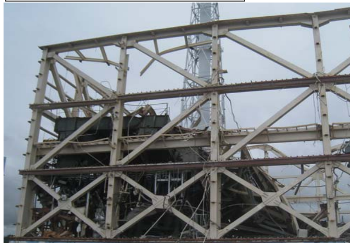
オペフロ全景（南東面）
