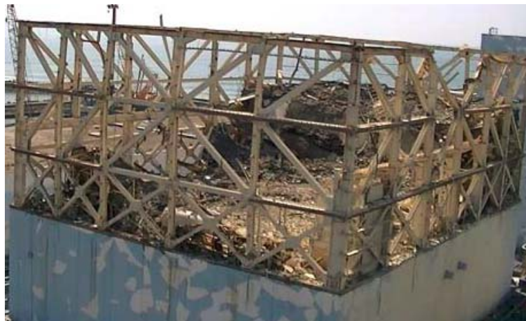
オペフロ全景（北西面）
