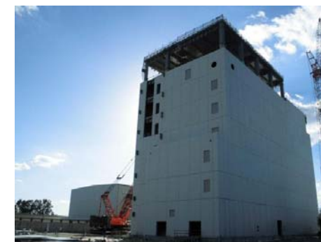
大型休憩所建設状況 平成26年11月時点
