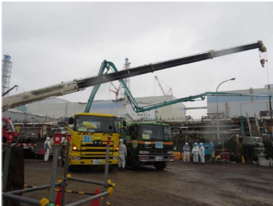
充填作業状況
