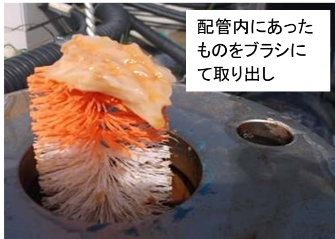
流量計下部の配管 (流量計取り外し)
