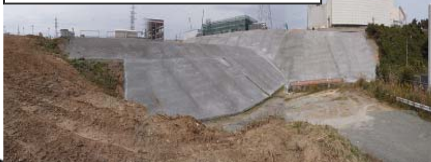
【写真①】法面モルタル吹付施工状況
