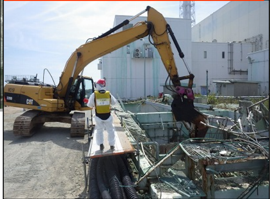
逆洗弁ピット内瓦礫撤去状況
