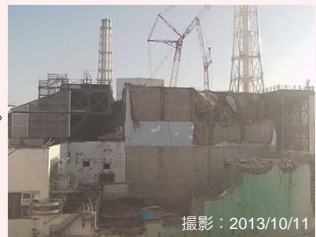
大型ガレキ撤去後
