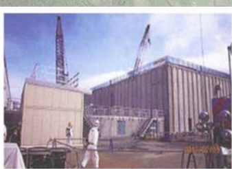
灰スラッジ一時保管施設
