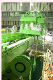
燃料取り出し状況
