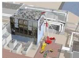
原子炉建屋上部のガレキ撤去
