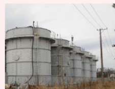
堰カバー設置前
