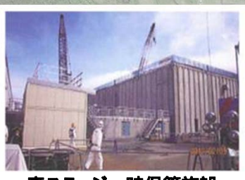
廃スラッジ一時保管施設
