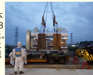
<凍結用冷凍機の設置作業>
