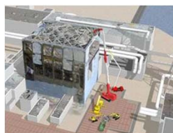
原子炉建屋上部のガレキ撤去
