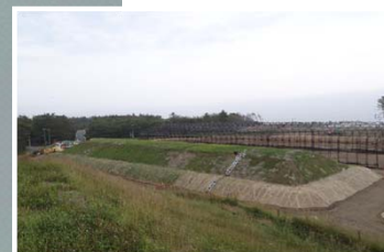
覆土式一時保管施設
