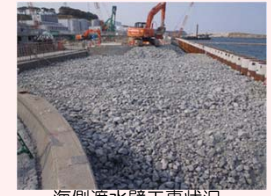
海側遮水壁工事状況 (1号機取水口側埋立状況)
