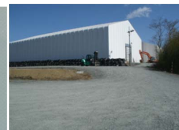
瓦礫保管テント
