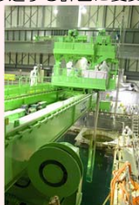
燃料取り出し状況
