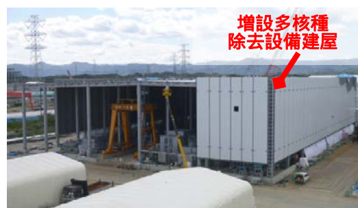
図4：増設多核種除去設備 建屋全景
