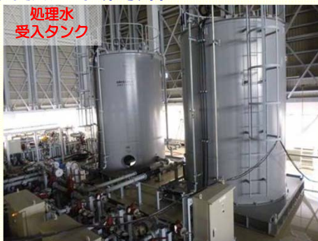
<増設多核種除去設備 設置状況>
