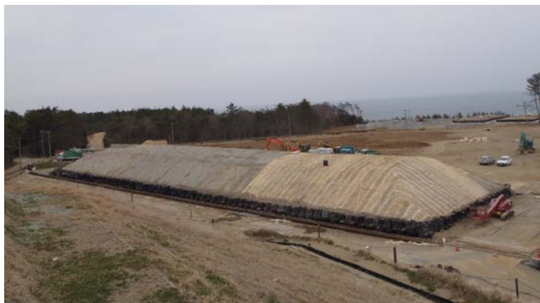
2 槽目の外観 (H25/3/25)
