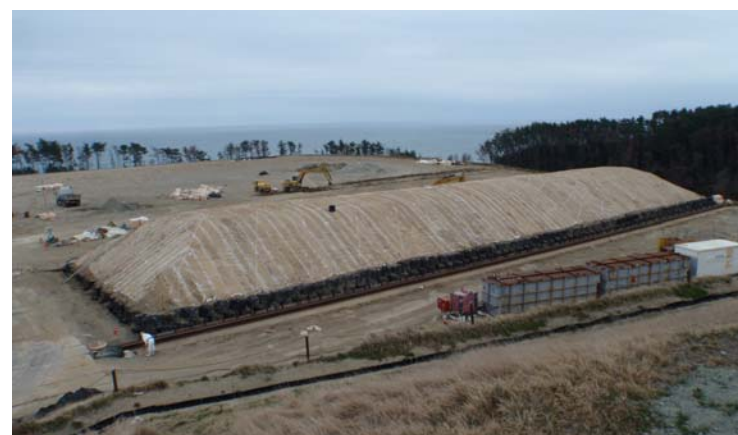
1 槽目の外観 (H25/3/27)
