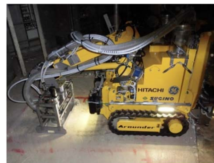
図1 除染時の作業ロボット
