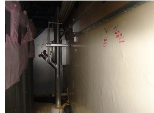
④ 西面（内壁）
