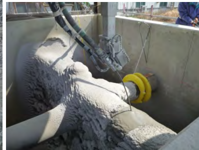
写真30-4 止水材の打設
