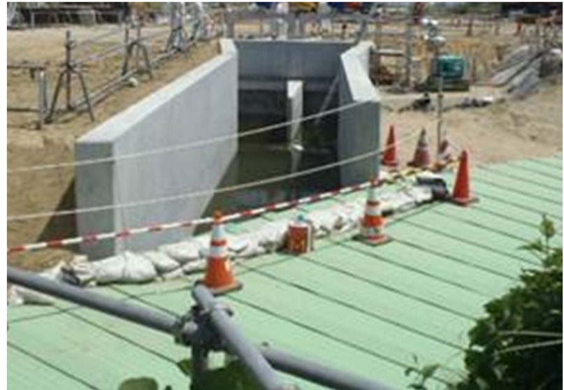
既設C排水路接続部構築状況（ライン①上部）
