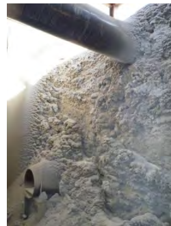
写真30-3 堰の構築完了
