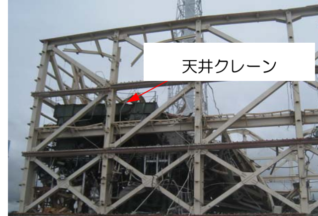
オペフロ全景（南東面）
