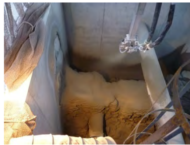
写真30-2 堰一般部の構築
