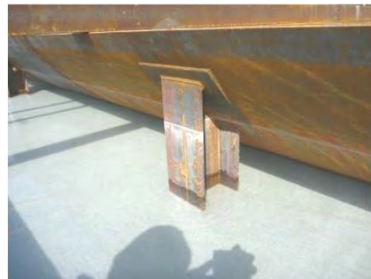
写真19-2 支持脚周囲の充填
