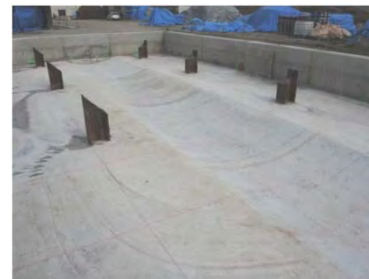
写真19-3 S/C下部の充填
