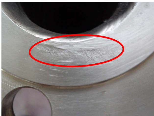
吸着塔 2 B 入口フランジ（上流側）の様子
