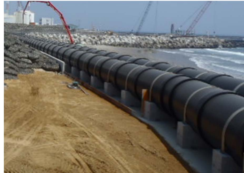
排水管設置状況（ライン②）
