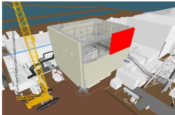
②壁パネル解体開始
