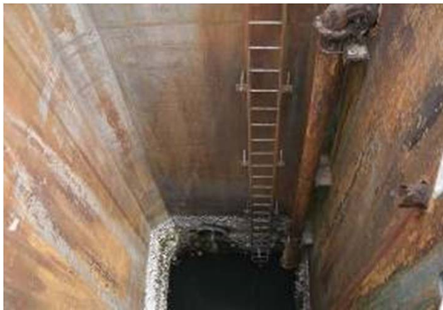
1号機上流側立坑
