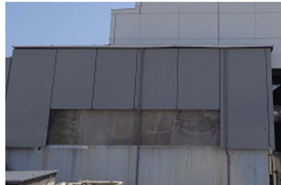
⑤ 西面（外壁）
