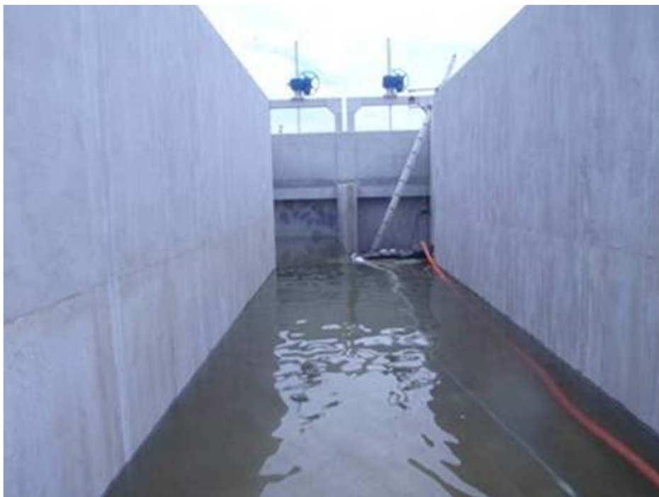
水門前開渠状況
