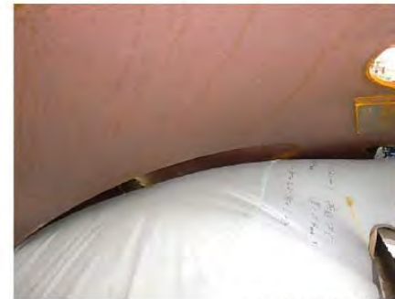
上部隙間詳細 (ベント管～ベントヘッド)
