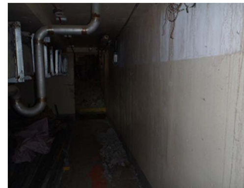
⑧ S F P 側壁面（東側）
