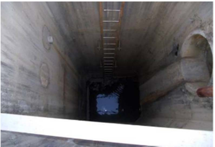
2号機上流側立坑
