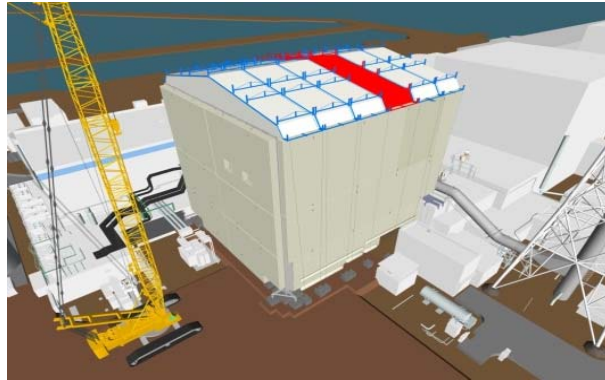
①屋根パネル解体開始
