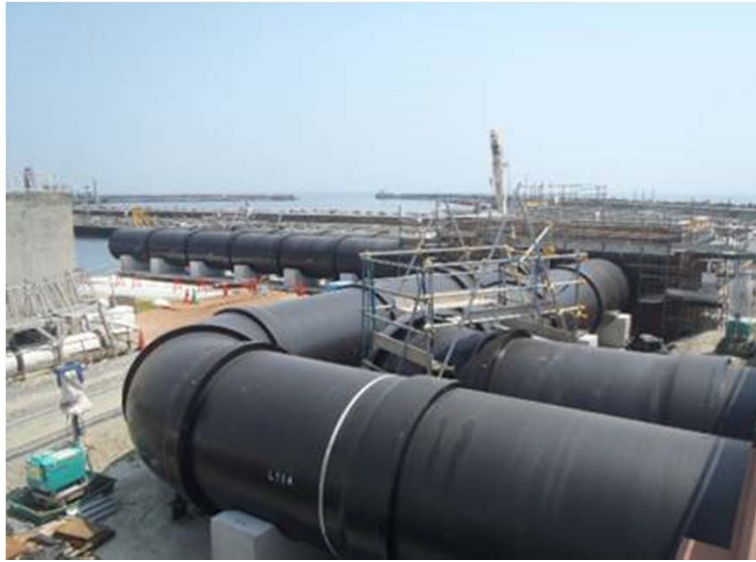
排水管設置状況（ライン③）
