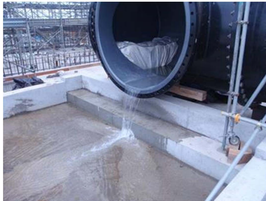
仮設水路放流状況
