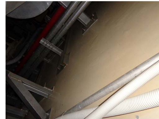
② 南面（内壁）
