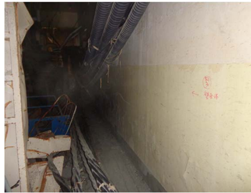
⑥ S F P 側壁面（東側）
