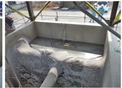
写真30-5 止水材の打設完了
