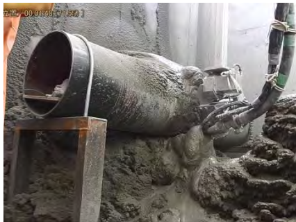
写真30-1 配管周囲の堰構築
