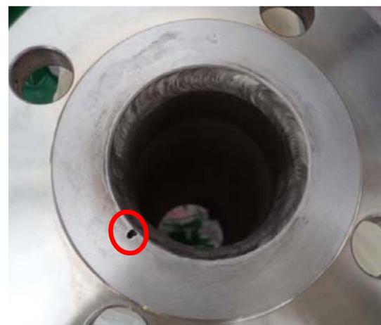
吸着塔 2 A 出口配管フランジ (下流側) の様子*
