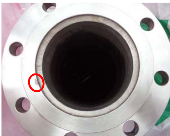
吸着塔 2 A 点検口フランジ部の様子
