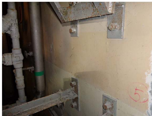
① 西面（内壁）
