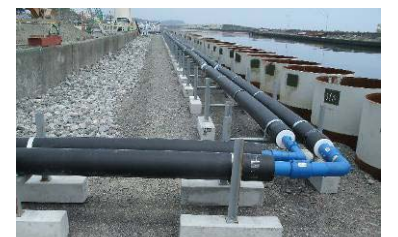
地下水ドレン配管設置状況
