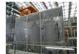
(放射性物質を吸着する設備の設置状況)
