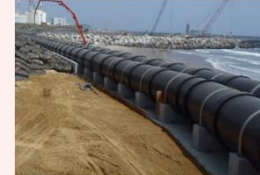
配水管設置状況②
