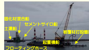
<港湾内被覆作業の様子>
