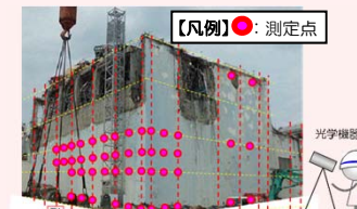
傾きの確認(外表面の測定)
