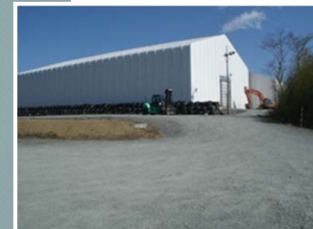
瓦礫保管テント
