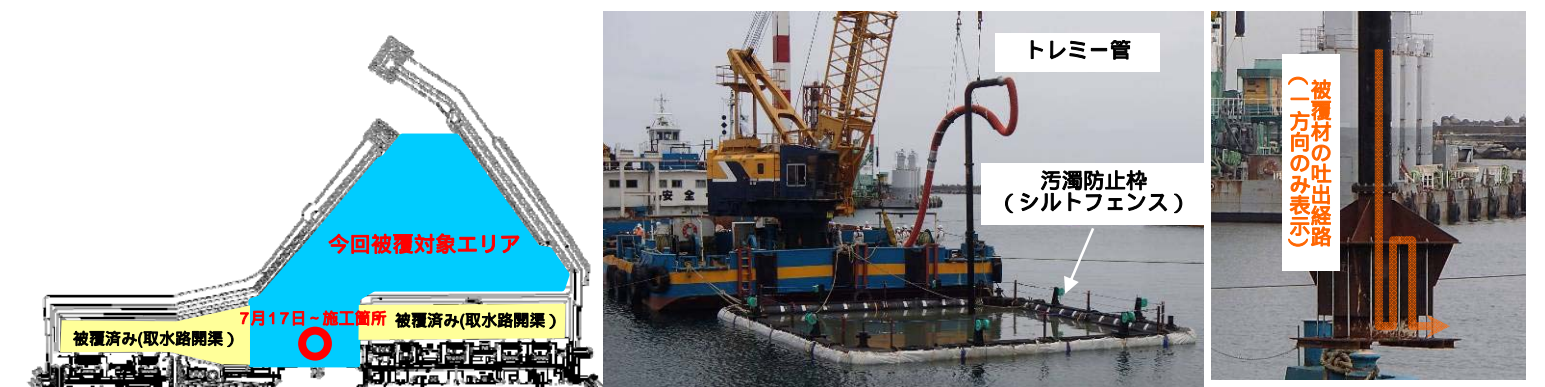
トレーマ管先端部（被覆材吐出部）
