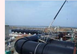
配水管設置状況①
