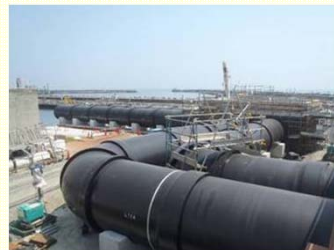
<配水管設置状況>
