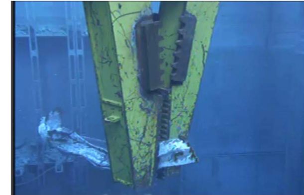
<使用済燃料プール内瓦礫撤去作業状況>
