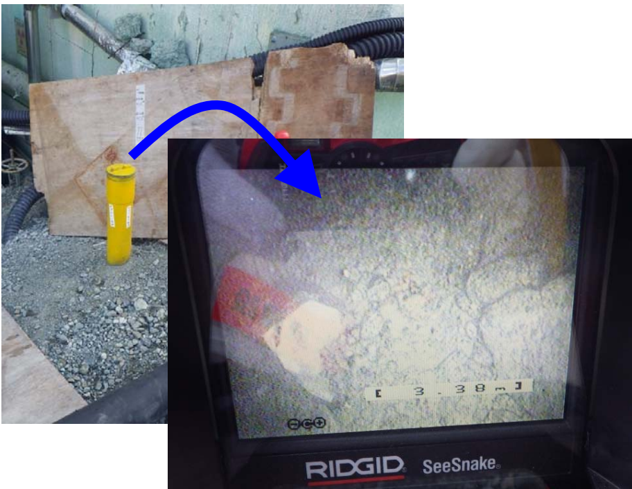
No.48ピット内部
