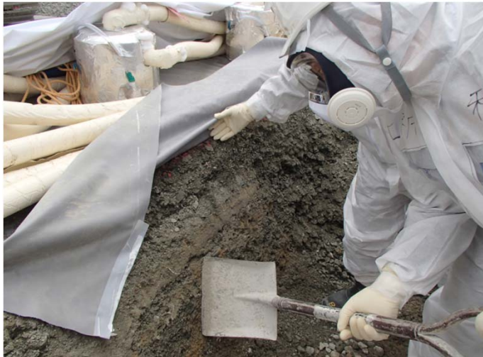
写真 凍結状況(上図、赤枠部分)
