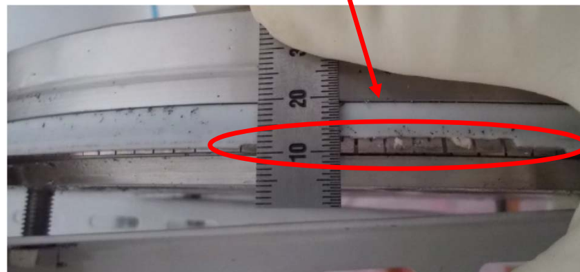
押さえプレート側面より撮影
