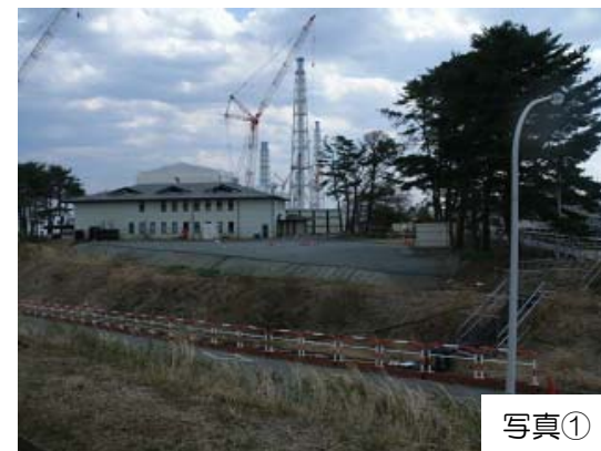
伐採、表土除去後の状況
