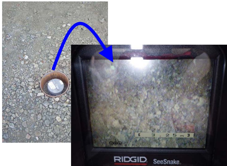
No.49ピット内部
