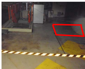
床面 コンクリート塗装面 (水除染済みだが, 固着性汚染のある部位)
