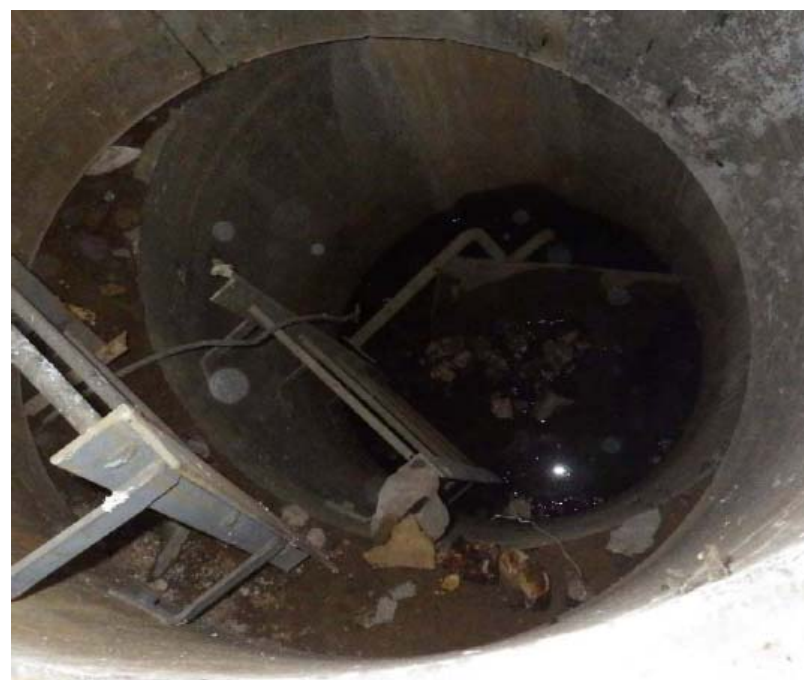
No.41ピット内部
