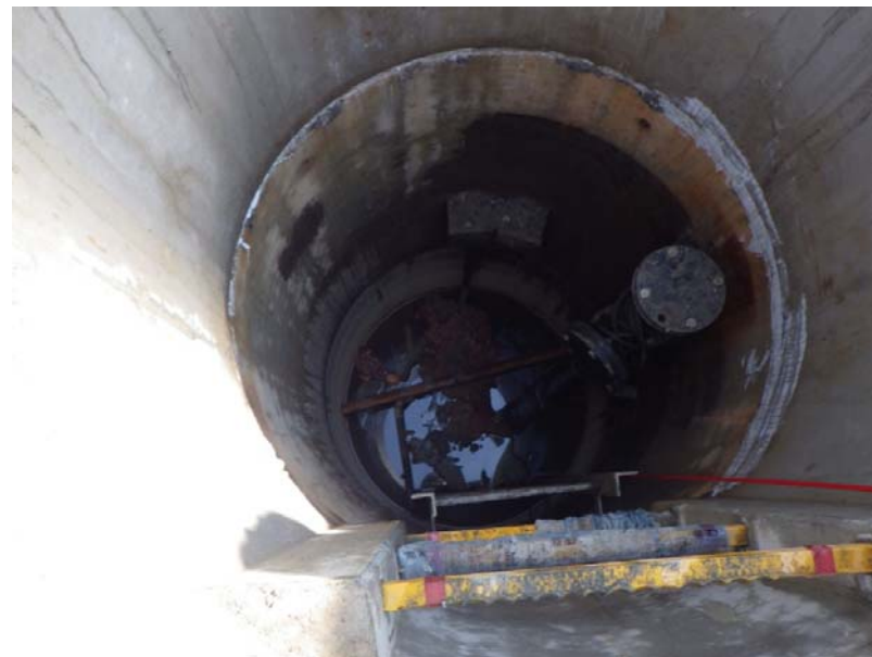
No.51ピット内部
