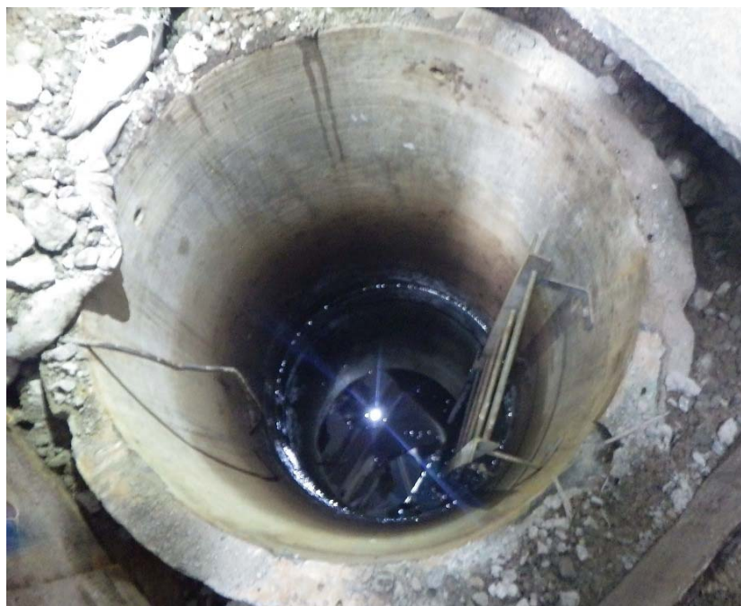
No.40ピット内部
