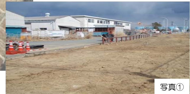
伐採、表土除去後の状況
