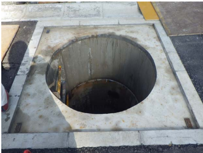
No.51ピット周辺状況
