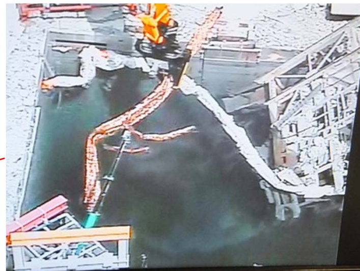
屋根トラス撤去(H26.3.28)
