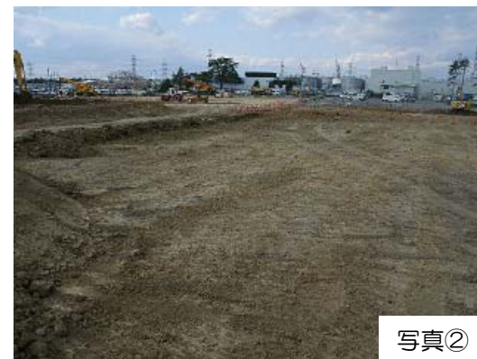
伐採、表土除去後の状況
