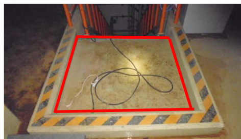
床面 コンクリート塗装面 (未除染)
